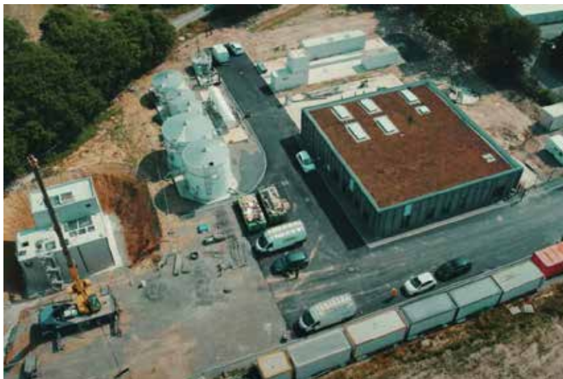
Unité pilote des Sables d'Olonne pour la production d'eau potable à partir d'eaux usées traitées © Vendée Eau.
