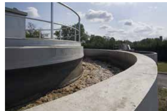
Réutilisation des eaux usées traitées dans le bassin de l'Adour © Agence de l'eau Adour-Garonne
