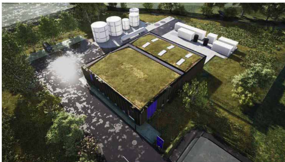
Usine pilote du programme Jourdain © Véolia - Atelier RVL Architectes - Tours
