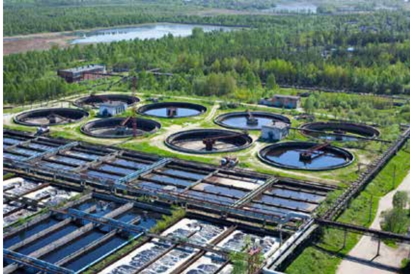
Station d'épuration © Mathieu Gollinvaux (DR)
