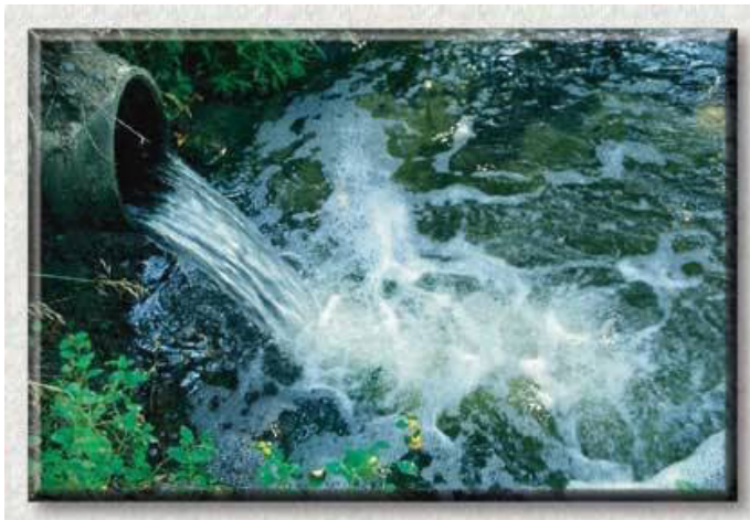
Rejet d'eau d'une station d'épuration en rivière © D. Touchard
